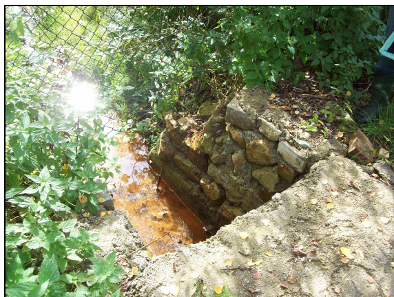
Foto 20 – Mostek M3 (pohled po vodě) - plot zasahující do průtočného profilu
