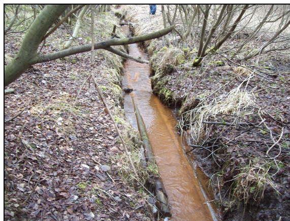
Foto 12 – Zpevnění koryta plůtky (pohled po vodě)
