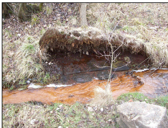
Foto 18 – Vývrat na pravém břehu s obnaženým opevněním
