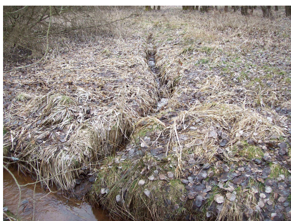
Foto 14 – Zaústění povrchového odvodnění
