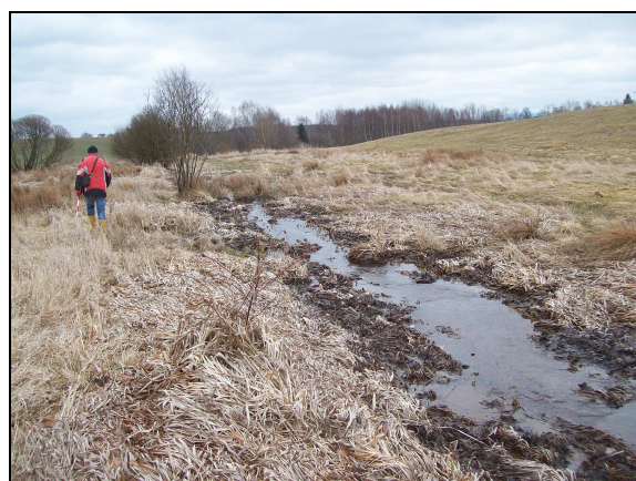
Foto 5 – Tok pod propustkem zcela zanesený sedimentem (pohled po vodě)
