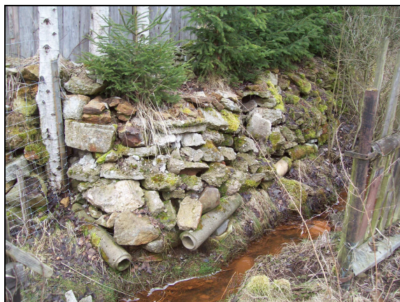
Foto 26 – „Opevnění břehu a vyústění odvodnění“
